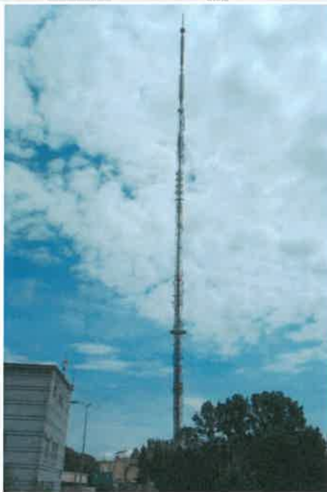
Fot. 1. RTCN Gdańsk / Chwaszczyno – widok obiektu
