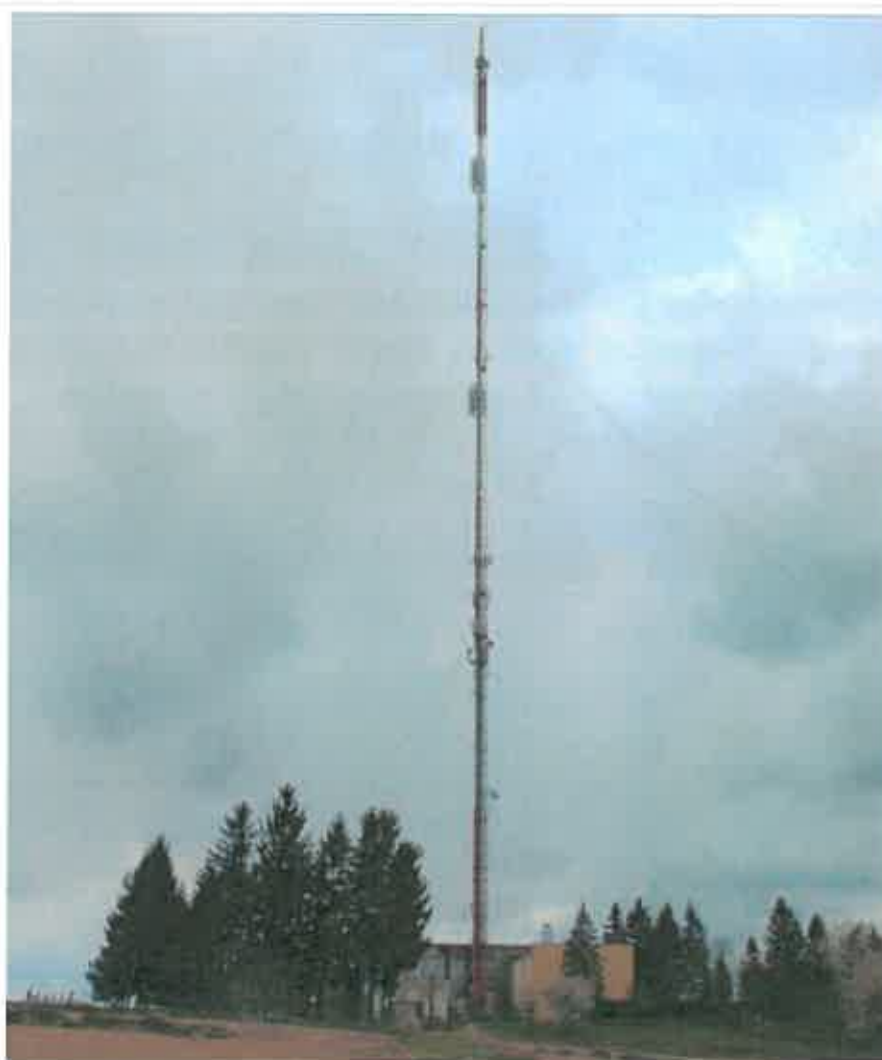
Fot. 1. RTCN Gdańsk / Chwaszczyno – widok obiektu
