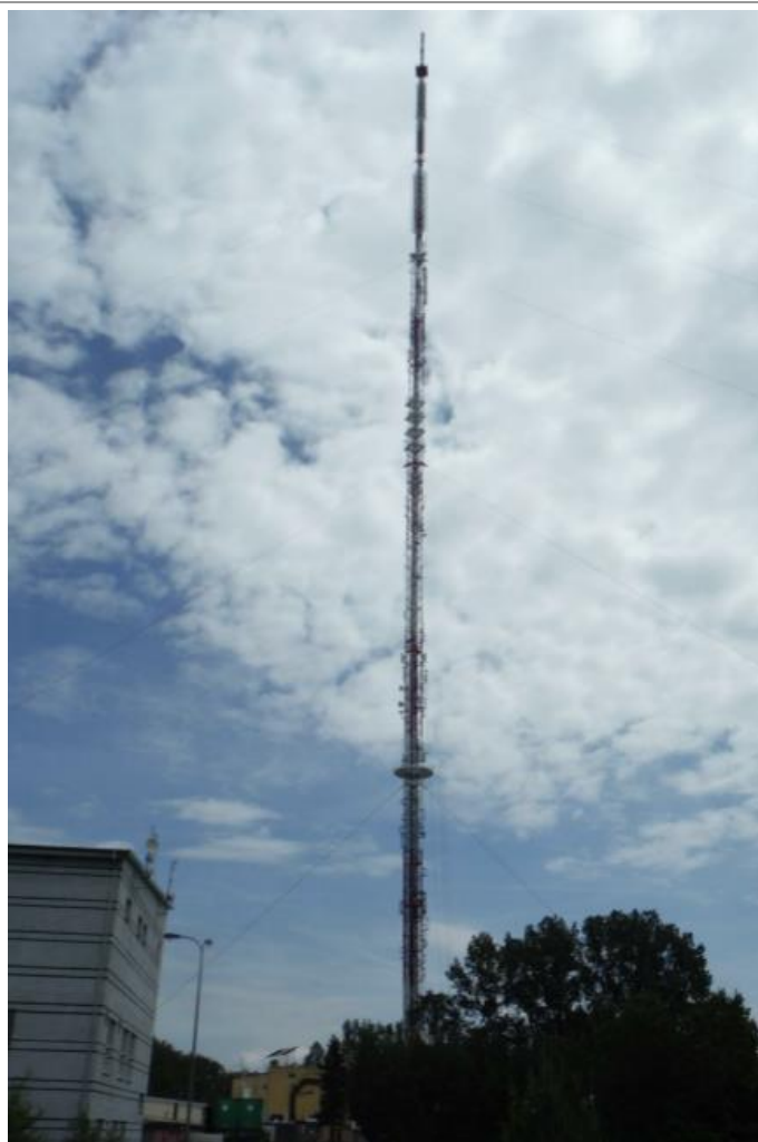
Fot. 1. RTCN Gdańsk / Chwaszczyno – widok obiektu
